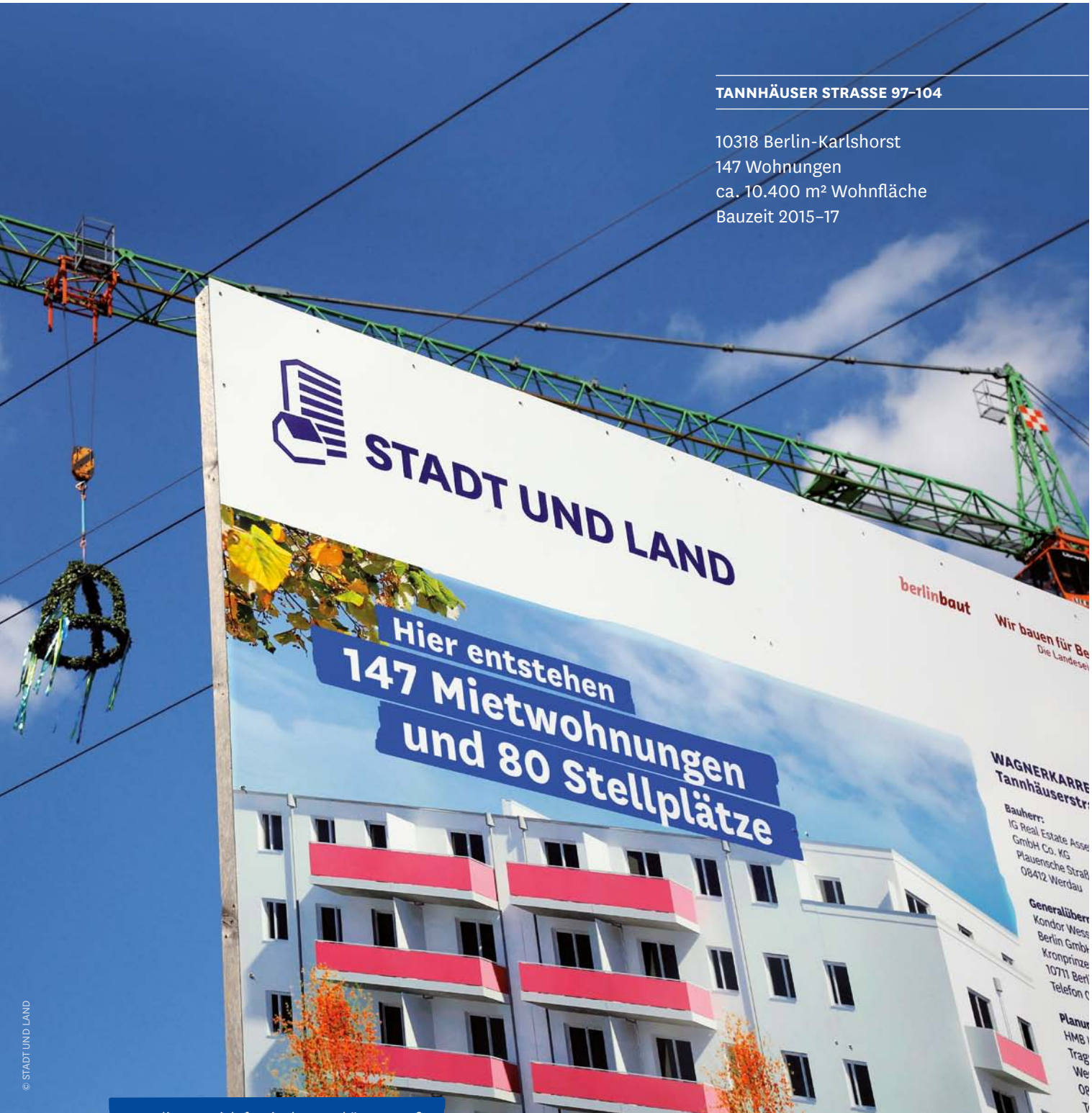
20. Juli 2016: Richtfest in der Tannhäuser Straße
