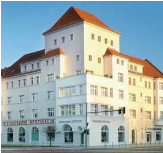
In ihrem komplett sanierten Gebäude am Sterndamm 7 in Treptow vermietet die STADT UND LAND eine trägergestützte Demenz-WG.
