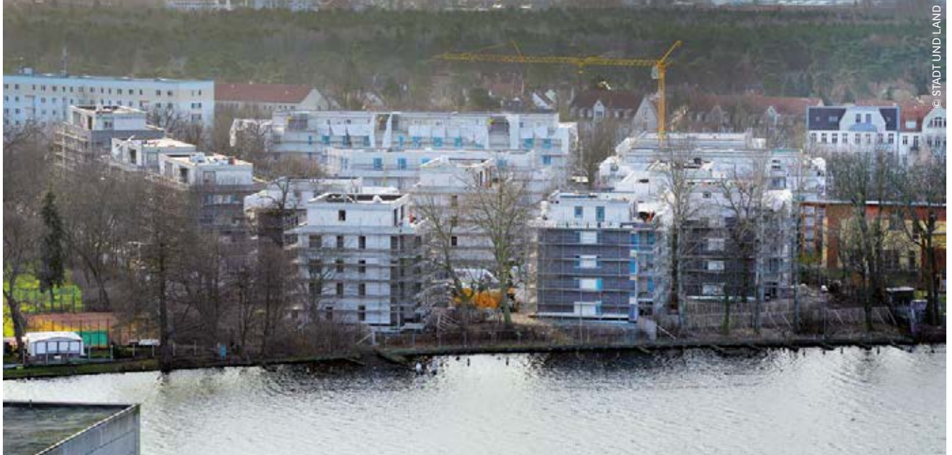
Blick über die Spree auf das Baufeld
