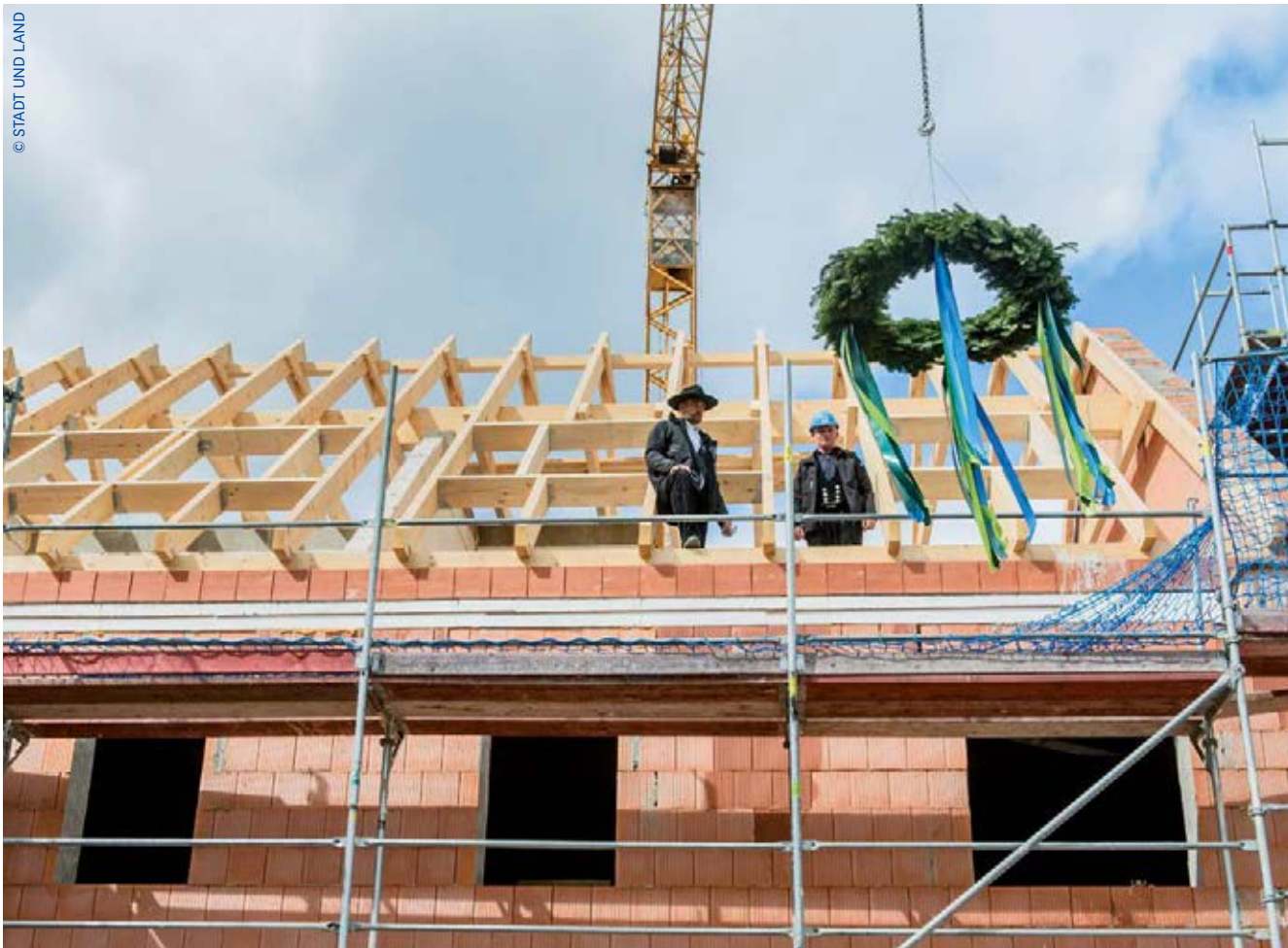
Im April 2016 wurde in der Zescher Straße Richtfest gefeiert
