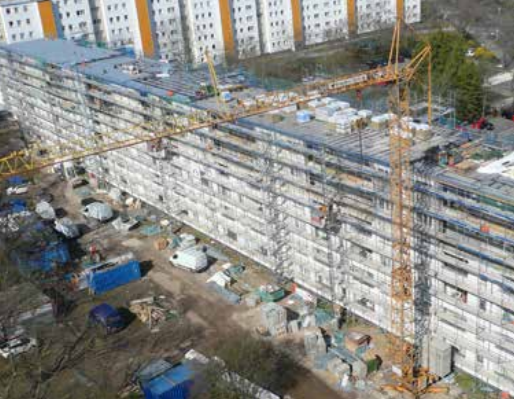
Zwei Etagen extra: In der Barnetstraße 60 bis 67 wurde die Dachaufstockung in Holzbauweise errichtet.
