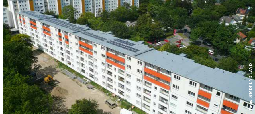
Zwei Etagen extra: In der Barnetstraße 60 bis 67 wurde die Dachaufstockung in Holzbauweise errichtet.
