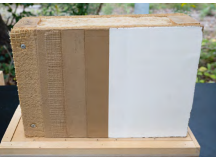
Musterwand für Trennwand aus Holz und Lehm
