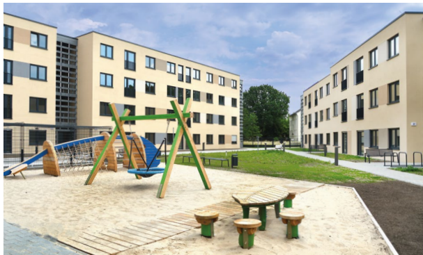
Modulare Unterkünfte für Geflüchtete in der Späthstraße, Ecke Chris-Gueffroy-Allee
