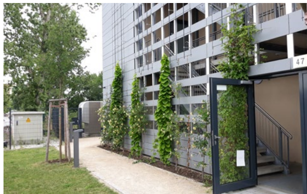
Der Pflegeaufwand für Fassadenbegrünung ist bei hochwachsenden Pflanzen groß.
